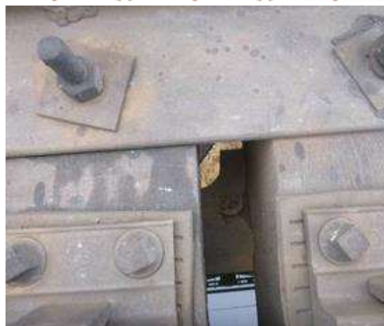
Выкол в верхнем поясном уголке (фото август 2017)
